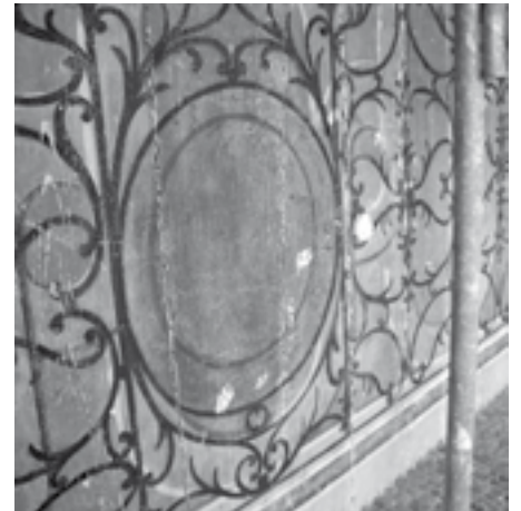
Die Nordfassade zu Beginn der Renovation
